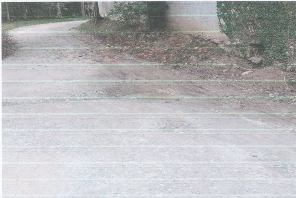
- Estrada Municipal Ohara, altura do nº 1.260.
